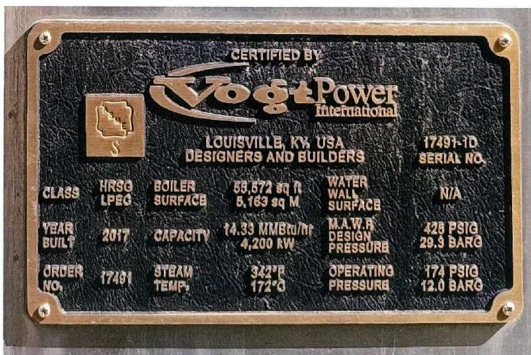
Name Plate HRSG LP EC : V17491-1D
